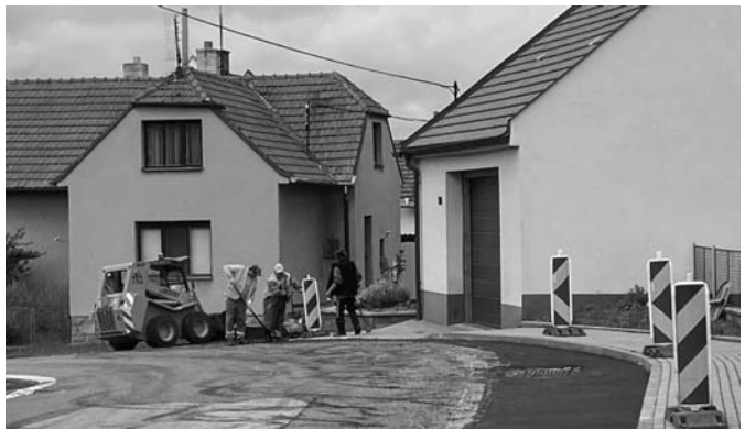
Na začátku července byla položením asfaltového povrchu dokončena oprava chodníku „Na Baňáku“. V dalších opravách místních komunikací se bude pokračovat v průběhu prázdnin.
