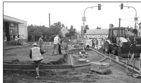
Výstavba chodníku a parkoviště
