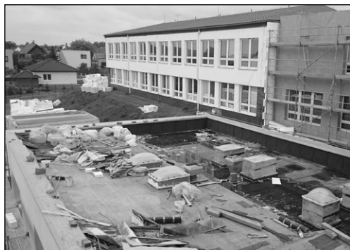
Oprava střešy nad ZŠ
